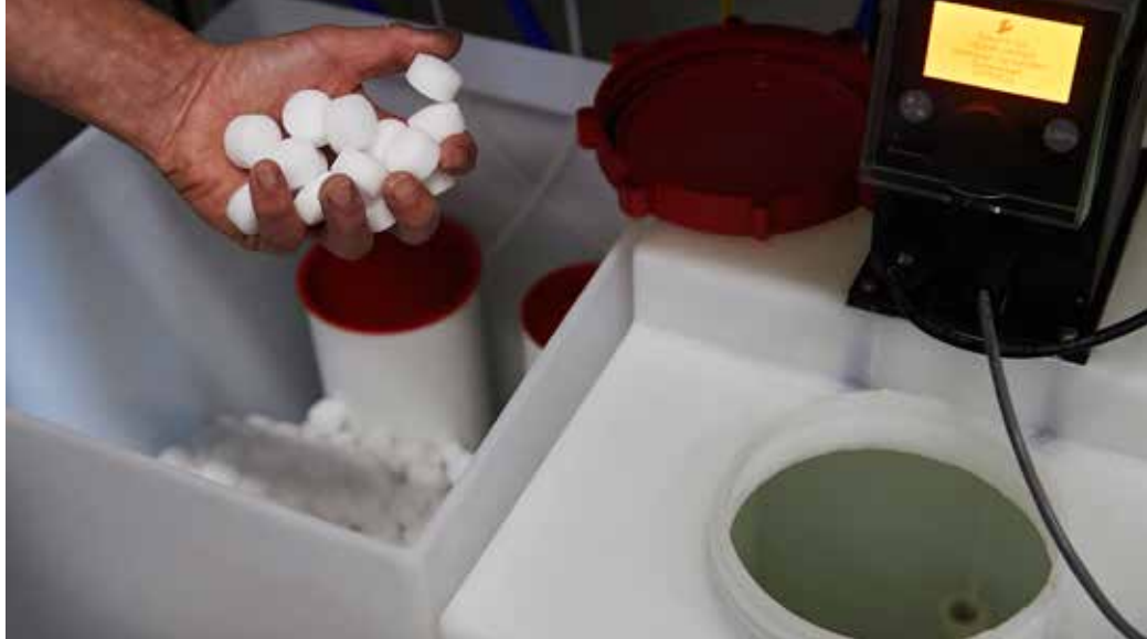
Anlægget fremstiller ugiftigt biocid med en elektrolyse af almindeligt salt, og medarbejderne slipper for at håndtere kemikalier.
